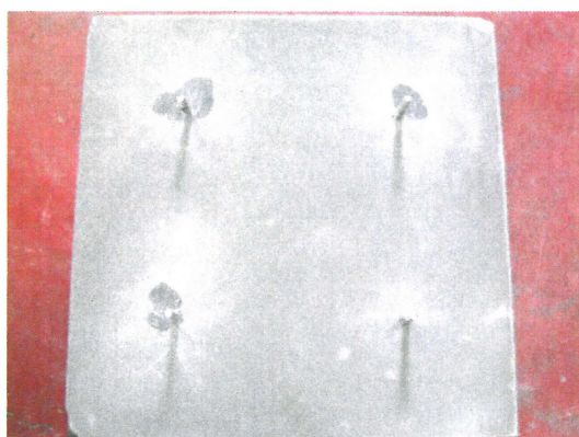
写真-5 モルタル板除去後の状況(M5)
